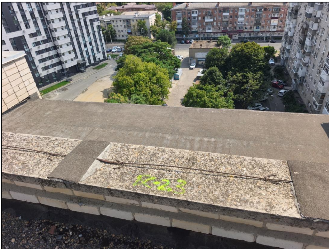
Идентификация конструктивных элементов кровли Объекта исследования. Блок-секция №2 в осях 30-33/Ж.
