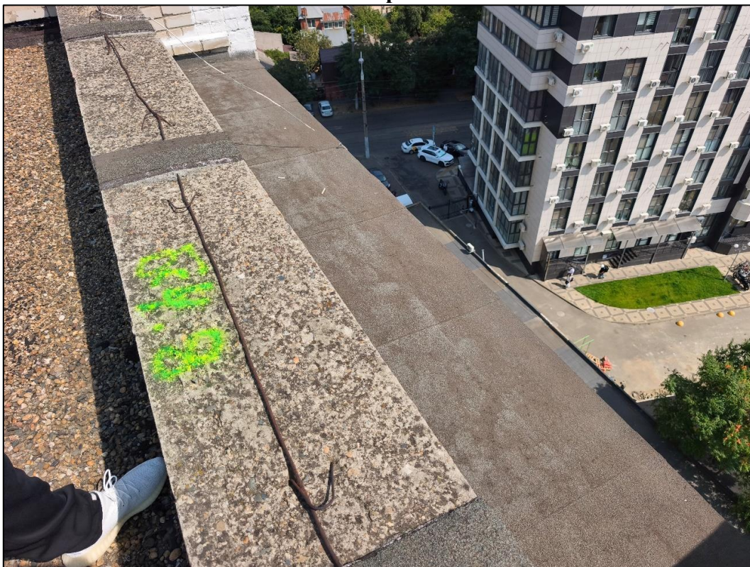
Идентификация конструктивных элементов кровли Объекта исследования. Блок-секция №4 в осях 11-14/Ж.
