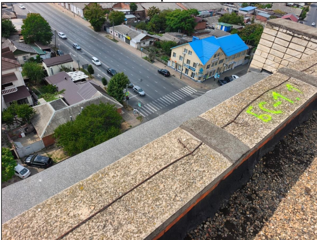
Идентификация конструктивных элементов кровли Объекта исследования. Блок-секция №1 в осях 40/Ж-Д.
