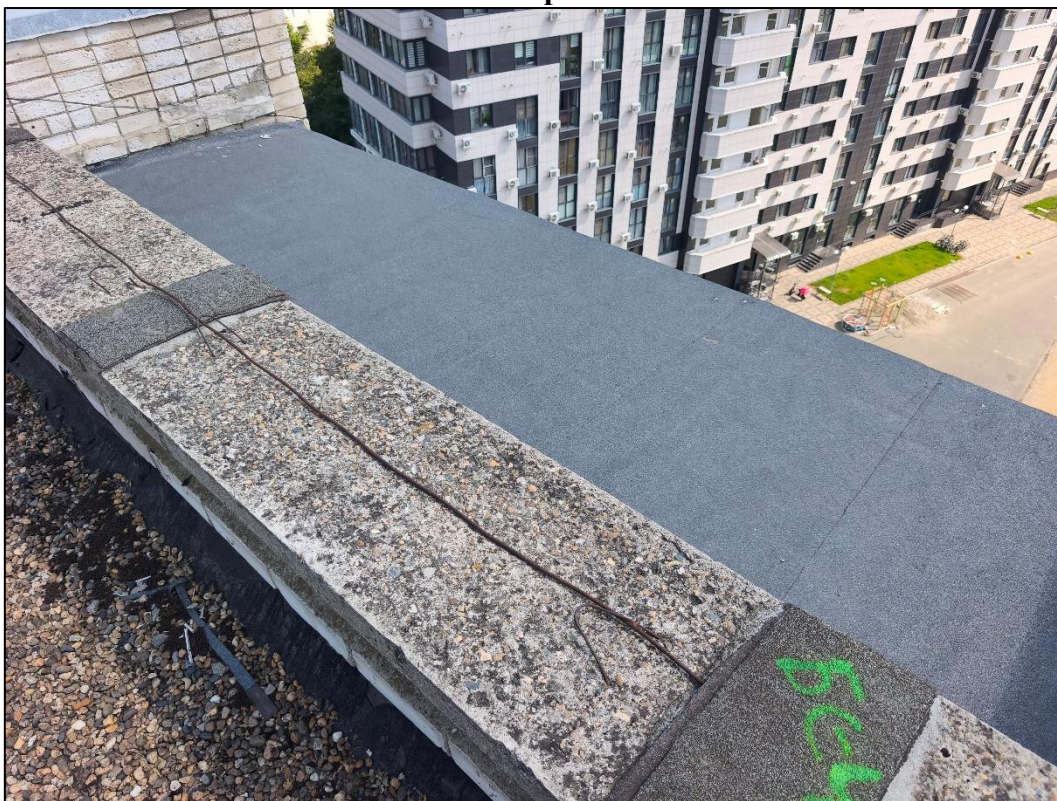
Идентификация конструктивных элементов кровли Объекта исследования. Блок-секция №4 в осях 14-17/Ж.
