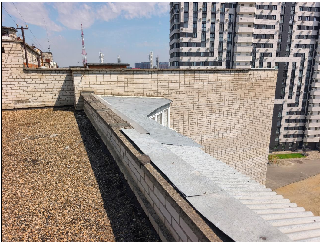
Идентификация конструктивных элементов кровли Объекта исследования. Блок-секция №2 в осях 33-35/Ж.
