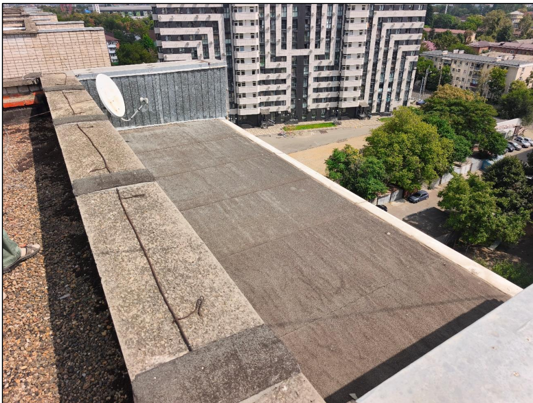
Идентификация конструктивных элементов кровли Объекта исследования. Блок-секция №1 в осях 35-38/Ж.
