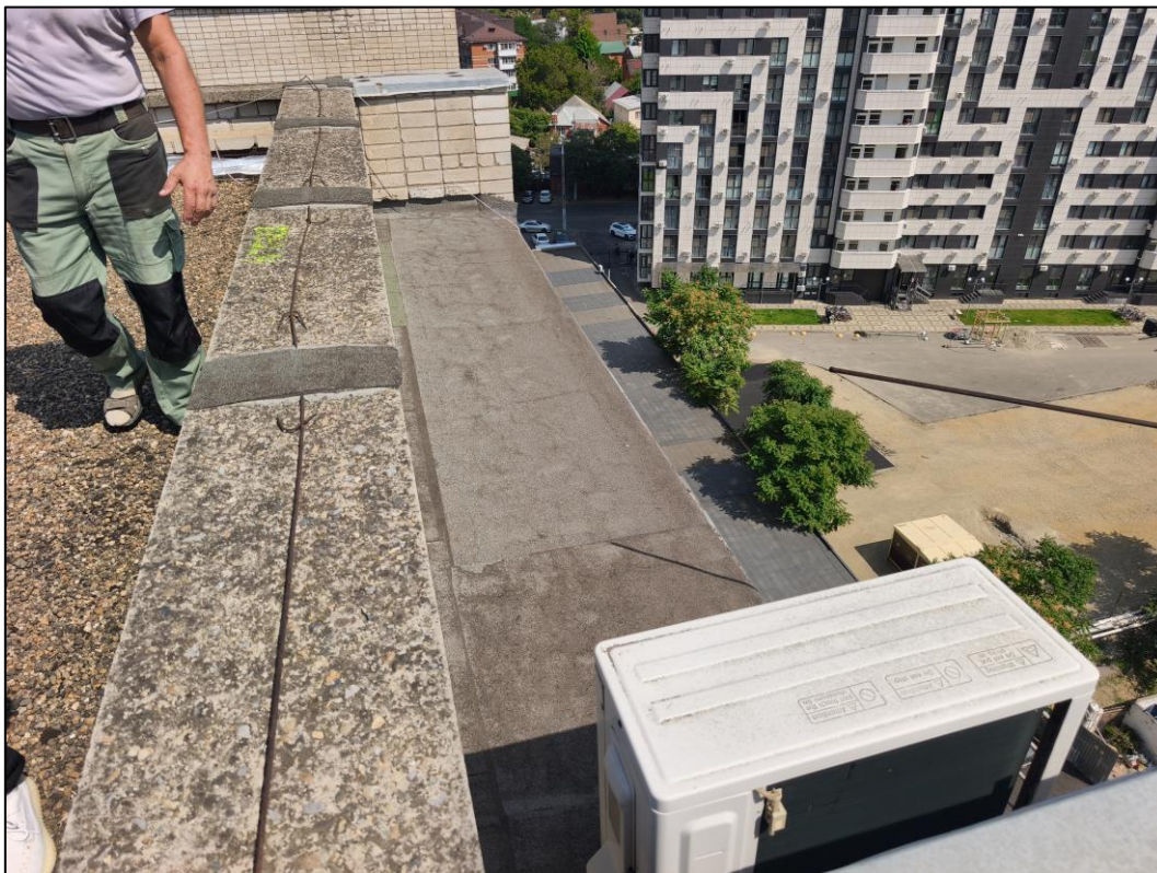
Идентификация конструктивных элементов кровли Объекта исследования. Блок-секция №2 в осях 27-30/Ж.
